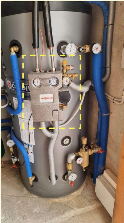
Dettaglio impianto solare termico esistente, integrato con il nuovo sistema PDC Templari
