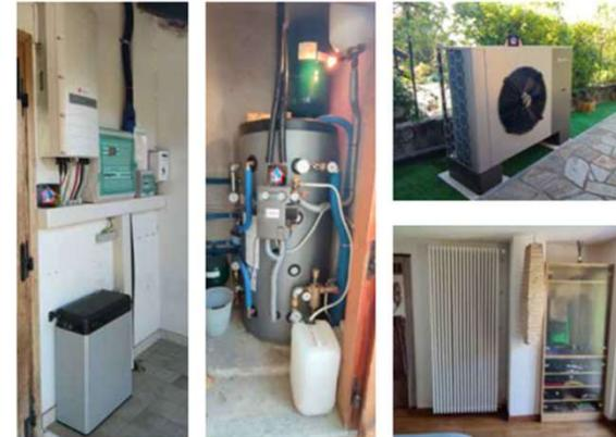
IS ENERGY PARTNER INSTALLATORE DELL'ASSOCIAZIONE CASA GAS FREE PER IL PIEMONTE. HA INSTALLATO UN IMPIANTO FOTOVOLTAICO DI POTENZA DASI A 8,8 KWP UTILIZZANDO 22 MODULI SUNPOWER MODELLO MAX3 DA 400 WATT CIASCUNO E UN INVERTER SOLAREDEE MODELLO SE6000HD. L'IMPIANTO SOLARE È DOTATO ANCHE DI 22 OTTIMIZZATORI DI POTENZA SOLAREDEE E DI UNA BATTERIA DI ACCUMULO LG CHEM 13 DA 13,1 KWH
