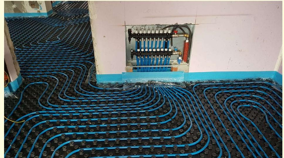
**Posa pannelli bugnati e tubazioni per sistema di riscaldamento radiante a pavimento
