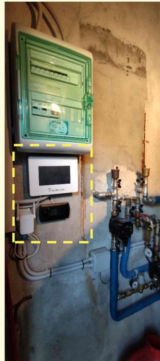
Dettaglio Centralina per la gestione della PDC e il monitoraggio/assistenza da remoto
