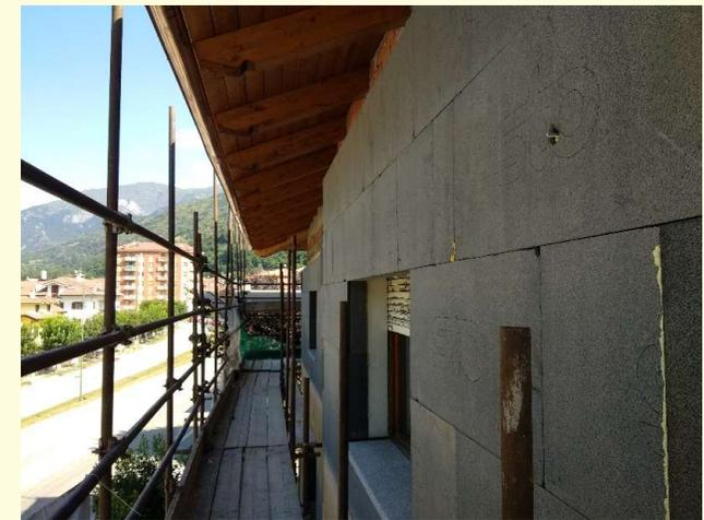
**Montaggio Ponteggio ed installazione cappotto
