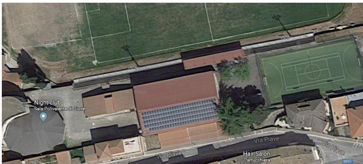
Figura 4: Nuovo impianto Fotovoltaico di 50 kWp sul tetto della palestra
