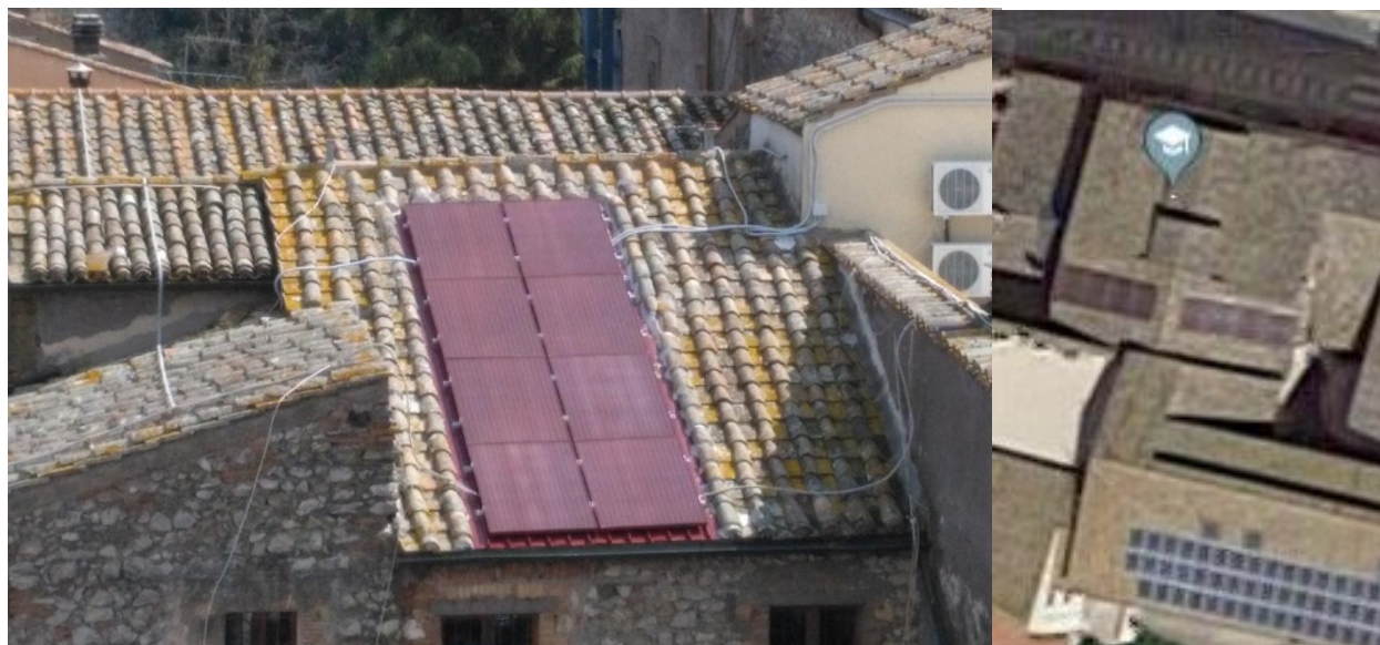
Figura 2: Impianto fotovoltaico con pannelli rossi e integrato nel tetto del Municipio
