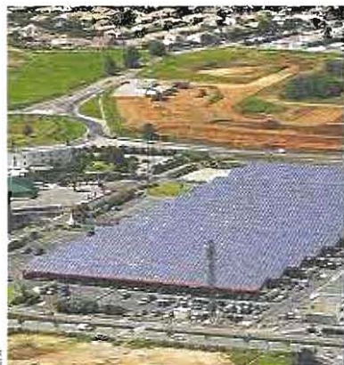
Un impianto fotovoltaico
