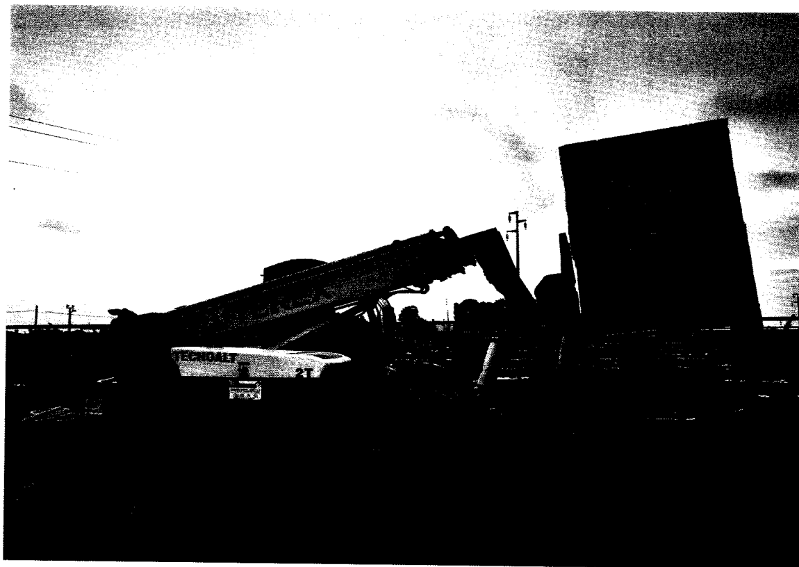
A Vulci, nel comune di Montalto di Castro (VT), vengono scaricati pannelli solari importati dalla Cina per un impianto in costruzione. In questa zona sono presenti molti parchi fotovoltaici di grandi dimensioni.
